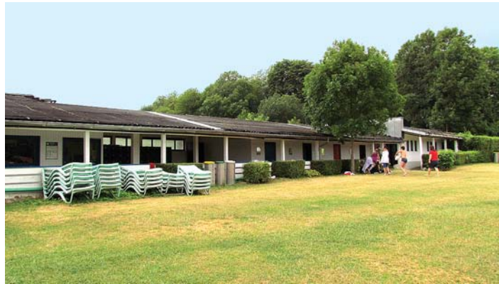
In die Jahre gekommen ist der Umkleide- und Sanitärtrakt im Erlebnisbad Engen. Deshalb wird der Eingangsbereich in erweiterter Form neu gebaut. Bild: Hering
